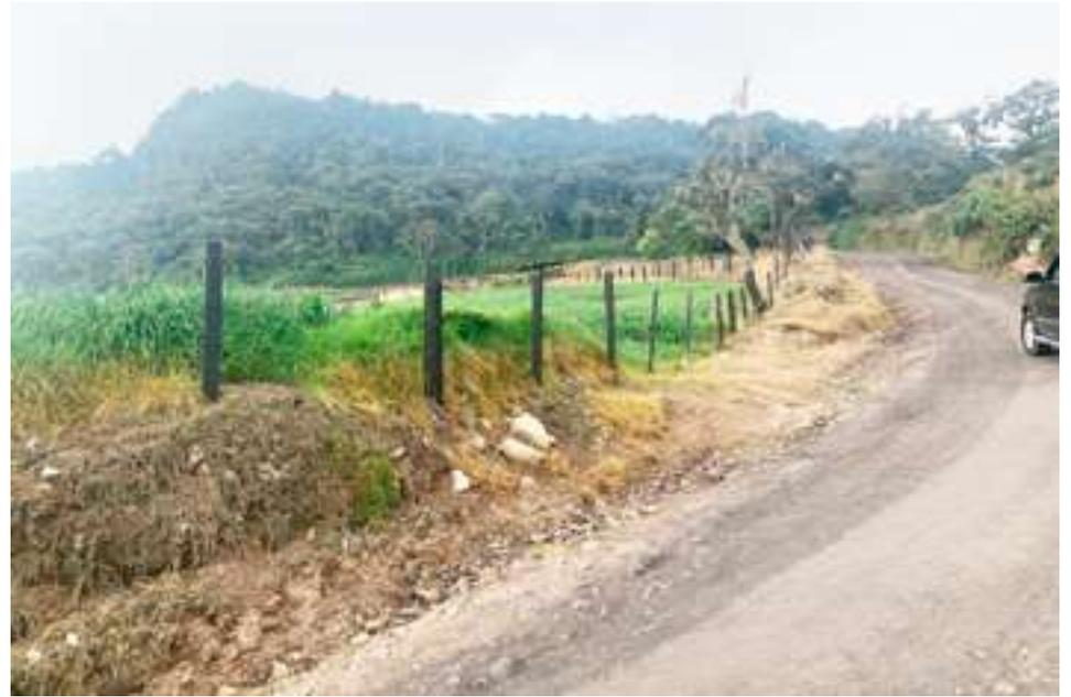
Vía después del mantenimiento con capa de recebo en el sector de Raspados
